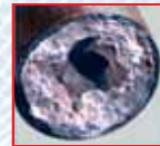
Wasserleitungsrohr mit Kalkablagerungen
